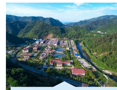
湖北十堰神定河污水处理厂 (18 万吨 / 日, MBR)
