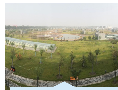
晋阳污水处理厂 (48 万吨 / 日, MBR)
