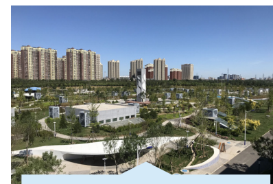
北京市门头沟区第二再生水厂 (8 万吨 / 日, MBR)
