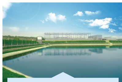
北京顺义引温济潮奥运配套工程 (10 万吨 / 日, MBR)
