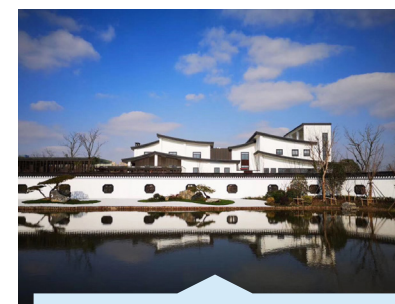
浙江杭州市临平净水厂 (20 万吨 / 日, MBR)
