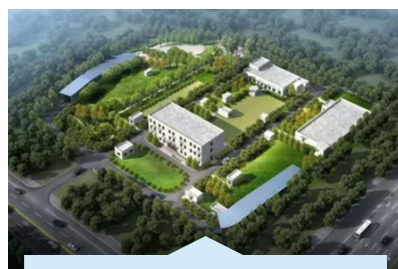
河南南阳科技产业园再生水厂 (3 万吨 / 日, MBR)
