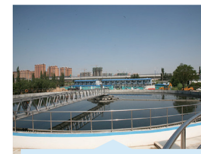
内蒙古呼和浩特市辛辛板污水处理厂 (20 万吨 / 日, 超滤)
